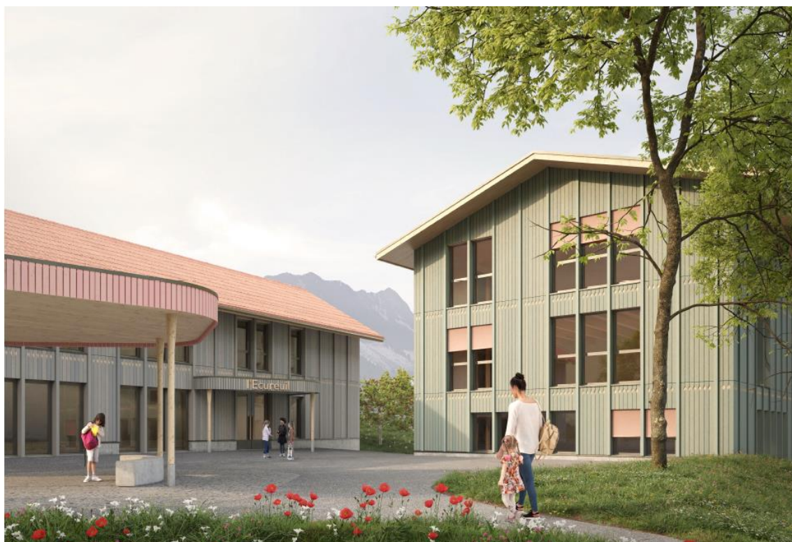
Vue sur les entrées depuis le préau principal
